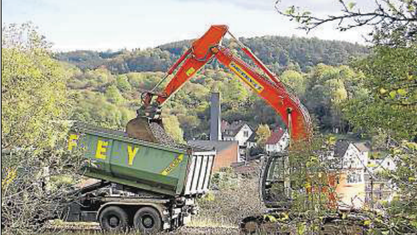
Wo früher die Dampfzüge, Güterzüge und der rote Balkan-Express über den Bahndamm brausten, luden im vergangenen Jahr Lkw den Schotter auf. Jetzt wird über die Vermarktung der ehemaligen Bahnflächen nachgedacht. (Foto: Lommel/Archiv)
