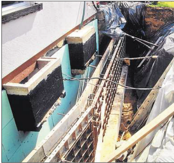
Eine Dichtwand mit Spezialbeschichtung zwischen Kellerwand und Erdreich soll die krebserregenden Kohlenwasserstoffe fernhalten. (Fotos: privat)
