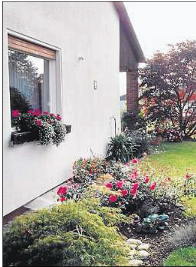
So sah die Wand vor der Sanierung aus. Der liebevoll angelegte Garten muss nun neu gestaltet werden.
